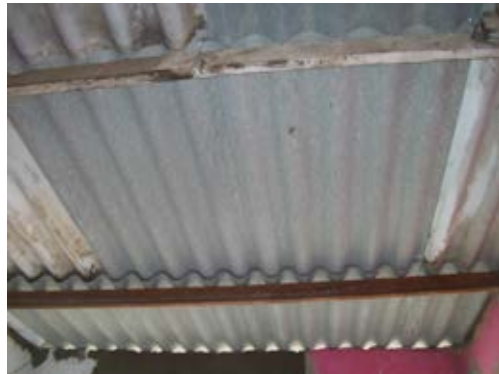
40. Instalaciones de Cubierta.
