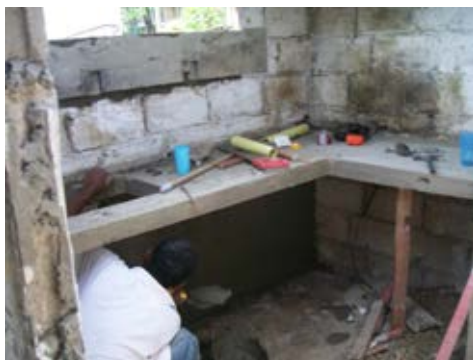
45. Pañete de paredes en la cocina.
