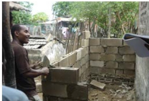
33. Trabajo de cimiento.
