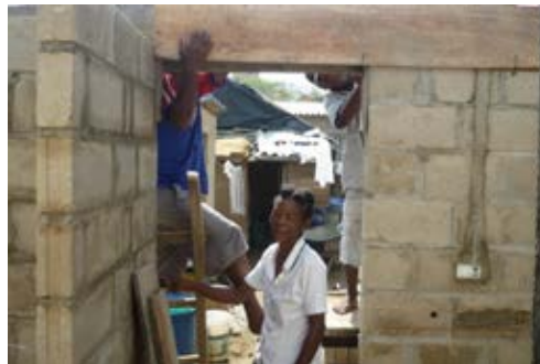
38. Trabajo de viga de amarre.
