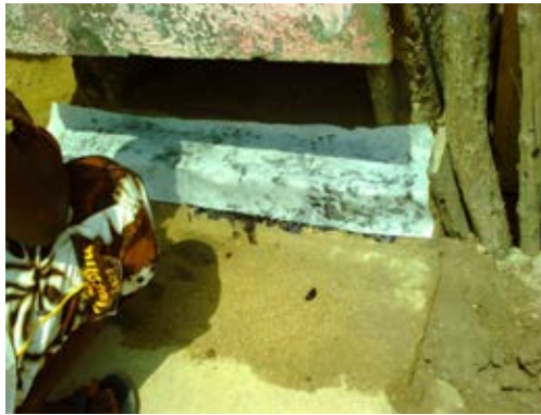
34. Impermeabilización de los cimientos.
