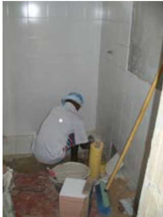
43. Instalaciones de enchape.
