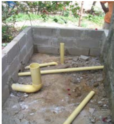
44. Instalaciones de Tubería Hidráulicas.
