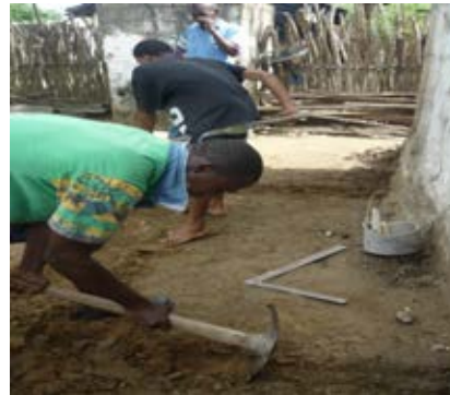
30. Excavaciones para Baño.
