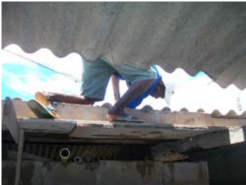
39. Instalaciones de Cubierta.
