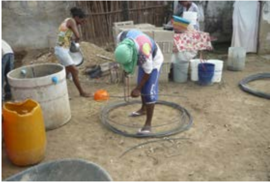
31. Acero utilizado en la obra.
